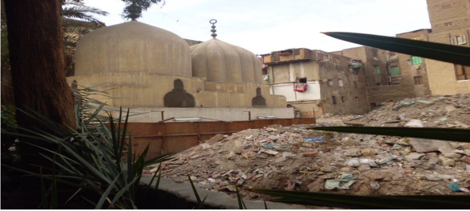
صورة ١: توضح الردم المتواجد خلف قبتي عاتكة والجعفرى، تصوير الباحثة.
